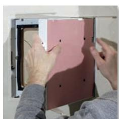
Nach dem Abrocknen der Spachtelmasse das Türblatt wie unter Punkt 4 beschrieben wieder einsetzen.
