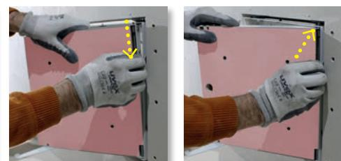
Das Türblatt mit dem Bolzenscharnier in die Aufnahme im Rahmen einsetzen.
