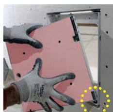
Insérez le vantail de la porte avec la charnière à boulon dans le support du cadre.
