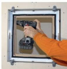
Die Maueranker mit den passenden Schrauben an das Metallprofil (bzw. an die Massivwand) verschrauben (siehe Tabelle).
