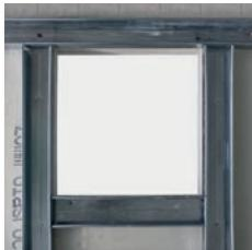
Bei Trenn- und Schachtwänden mit dem Bauausschnitt fluchtend einen Wechsel aus CW-Profilen erstellen.
