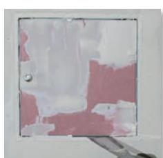
Überschüssige Spachtelmasse aus den Fugen zwischen Rahmen und Türblatt entfernen.
