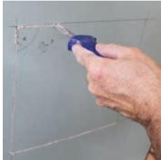
Bauöffnung an der angezeigten Linie ausschneiden.
